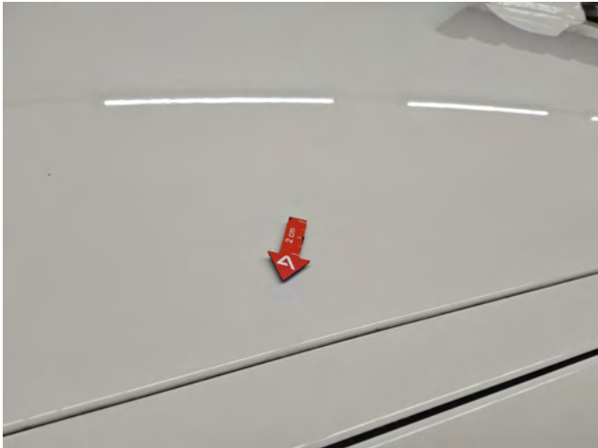
Bild 1: Außen, Dach, Delle , smart repair
